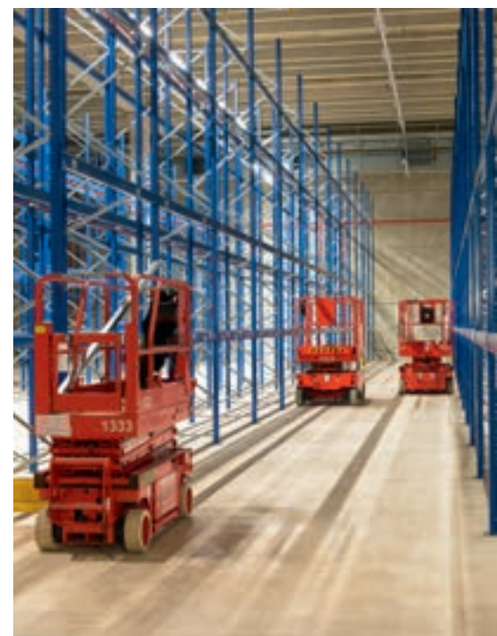
Mittagspause: Ein Großteil der Brandschutzrichtungen im Hochregallager ist bereits montiert.
