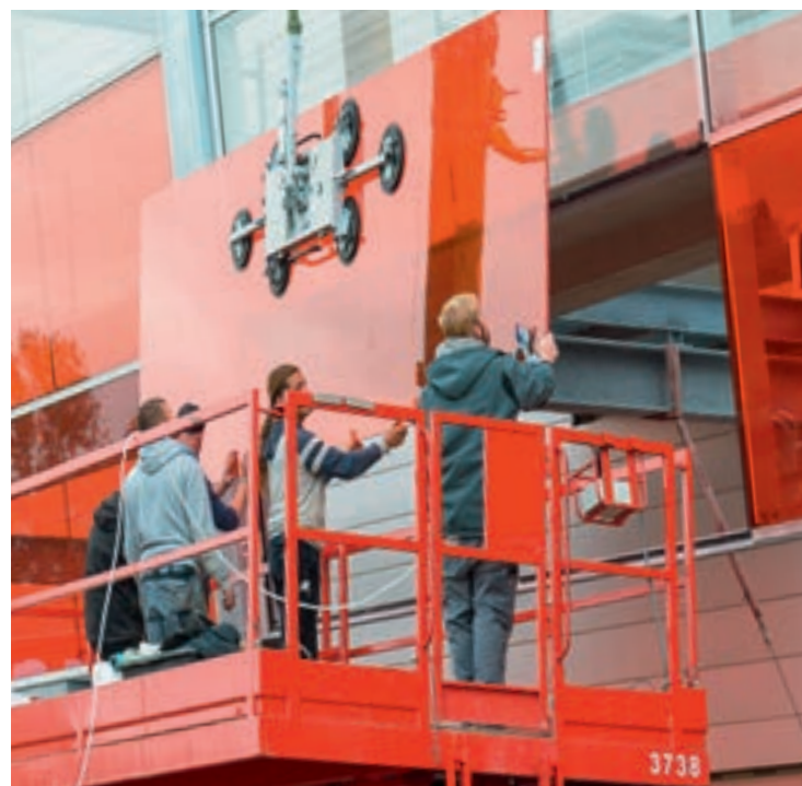
Per Kran werden die schweren Glaselemente exakt positioniert und vom Team montiert. Hier zählt sich besonders die große Arbeitsplattform aus.
