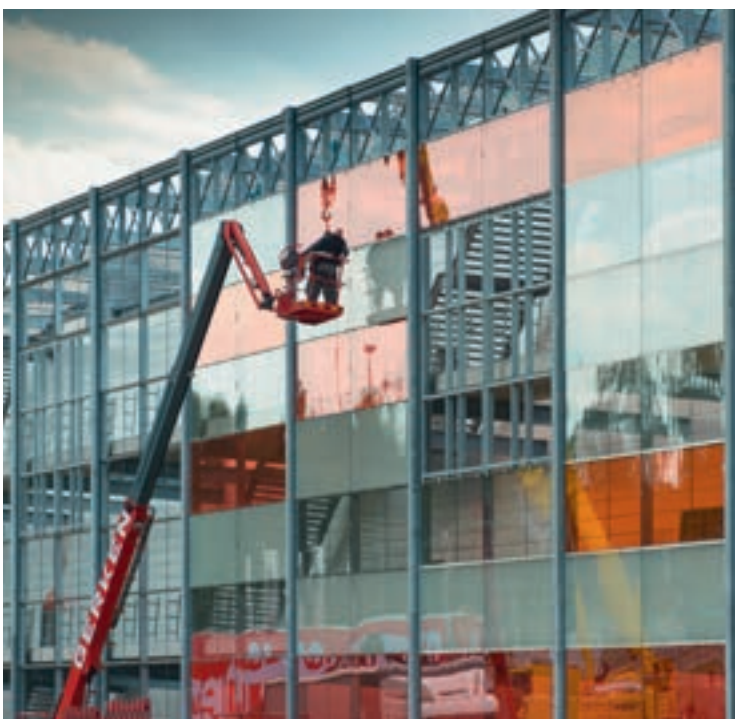
In die Fassadenkonstruktion aus verzinktem Stahl werden farbige Scheiben eingehängt, die der Fassade den besonderen Look verleihen.
