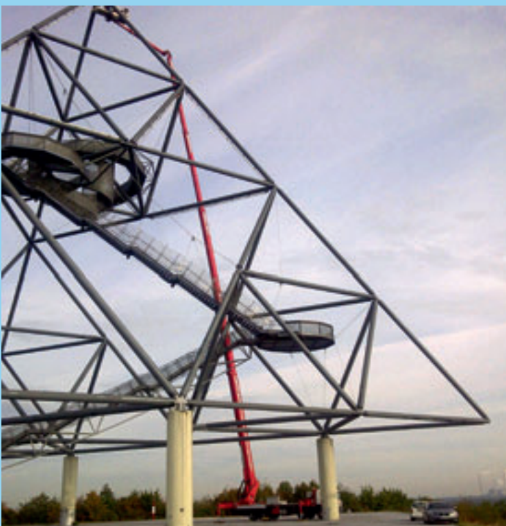
Hohe Korblast, große seitliche Reichweite und der geräumige Arbeitskorb machten die GL 53 G Allrad und GL 61 H Allrad zur ersten Wahl für die Inspektion des Tetraeders in Bottrop.
