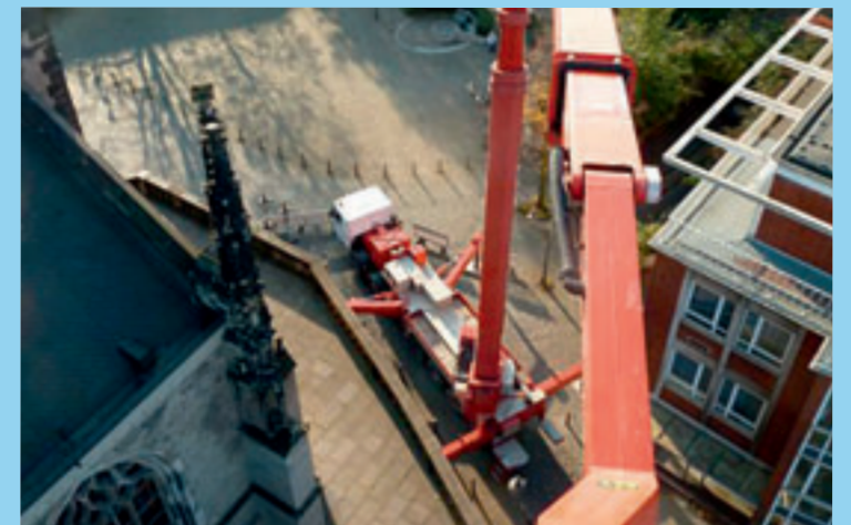
Dem Himmel ein Stück näher: Der Gutachter im Arbeitskorb der GL 84 G überprüft den Kirchturm der Salvator-Kirche in Duisburg. Der doppelte Korbarm lässt ihn dabei jede Prüfposition gut erreichen.
